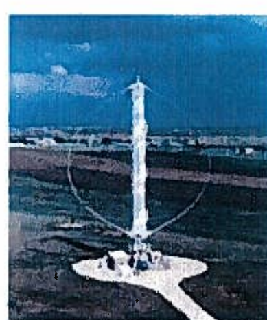
図3 ダリウス型風車
